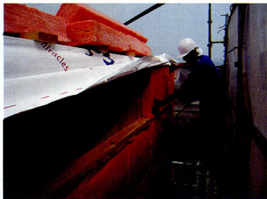
壁の付加断熱の納まり。写真はグラスウール厚100mmの付加断熱。軸組に構造用合板を打ち付け、そこに横桟を打って断熱材をはめ込んでいる。この外側に透湿防水シートを張り、縦胴縁を打って通気層を設ける
