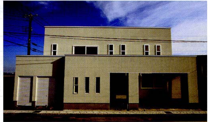
S邸外観。サイディング グ下地に塗装仕上げ
