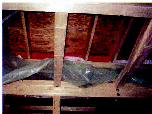
屋根の断熱の納まり。2×10の垂木の間にスペーサーを入れて通気確保したところに、グラスウール200mmを充てん。そこに防湿シートを張って気密を取り、内側に同45mmを付加する
