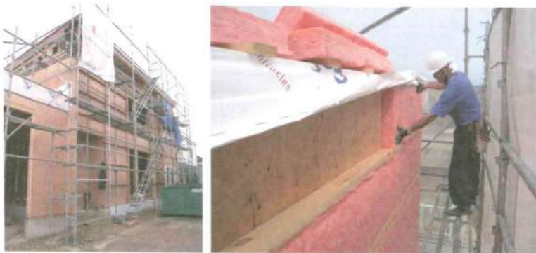
ここでも厚い断熱。壁は内外とも高性能グラスウール105mm合計210mm
